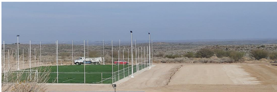
Trabajos de terracerías para cancha de futbol 7
